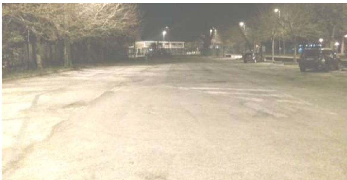
Vista del parcheggio attuale, al termine delle misurazioni in periodo notturno
