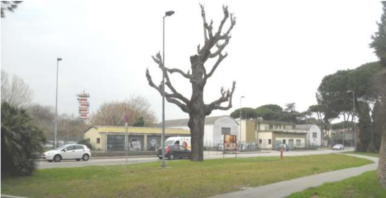
Area Fox, vista da sotto le mura, sul lato nord-est
