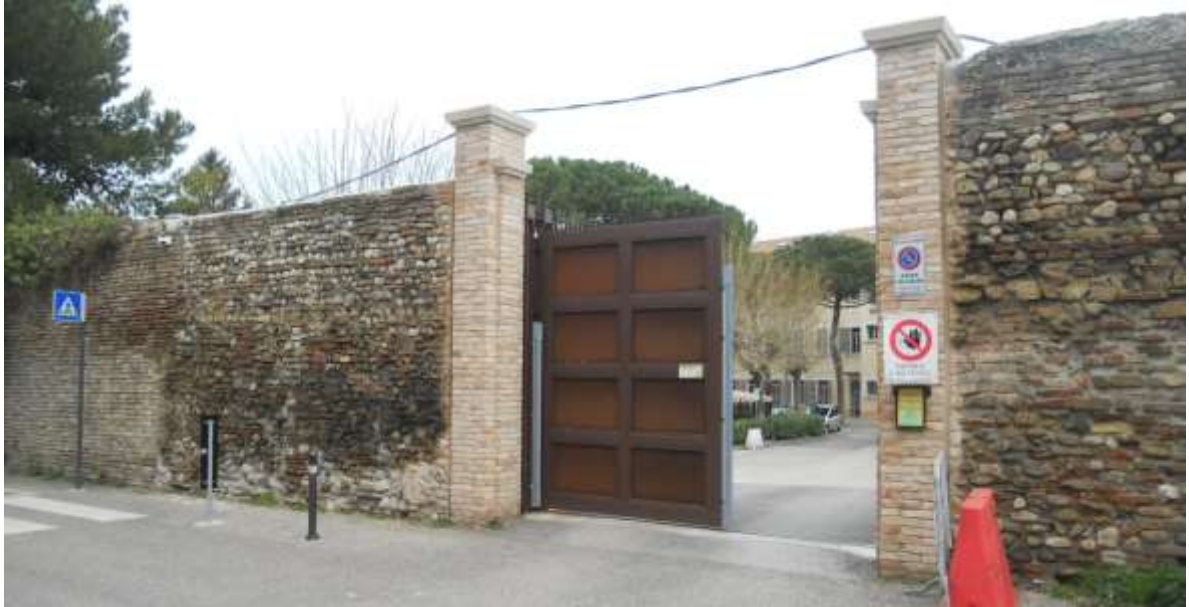
Dettaglio muro di cinta, in corrispondenza dell'ingresso all'Istituto Maestre Pie
