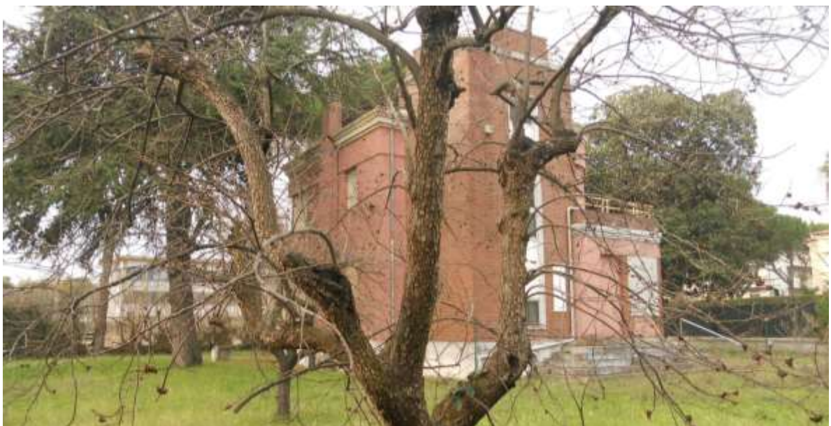
Abitazione vista dalla recinzione lato via Bramante
