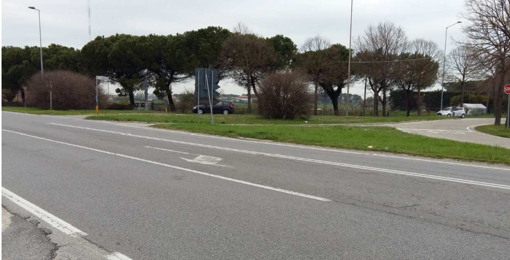
vista dell'attuale scincolo a raso tra la SS 16 e la Via Verenin
