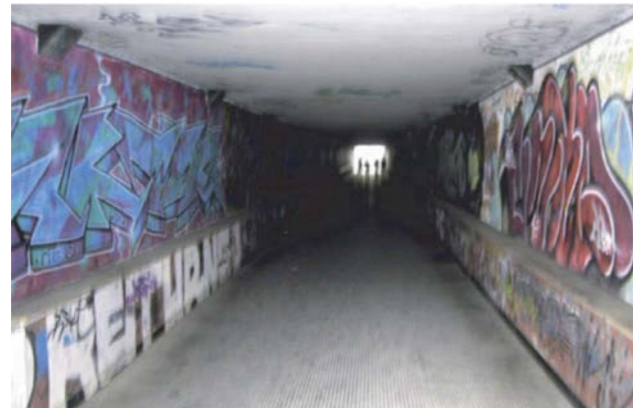
Sottopasso pedonale. Stato di fatto.
