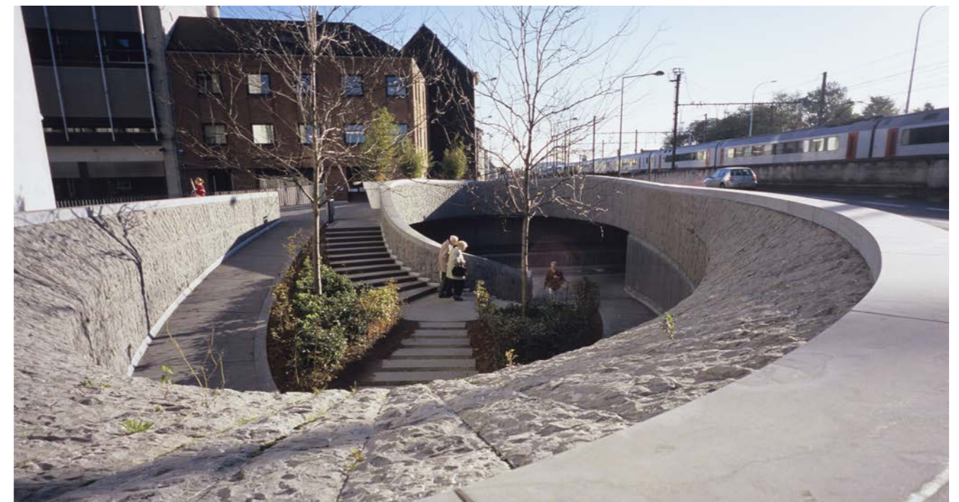
Sottopassaggio di Courtrai. Belgio
