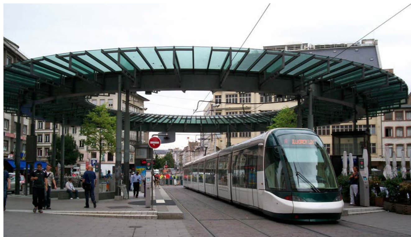
Stazione Tram di Strasburgo, Francia.
