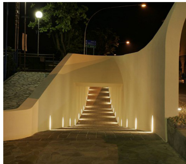
Sottopasso pedonale Sarnico (BG).
