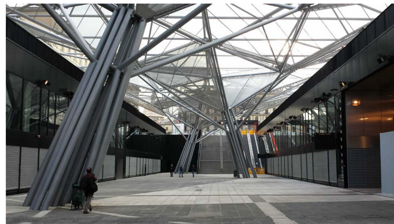
Stazione Garibaldi di Napoli. Progetto dello studio Dominique Perrault.
