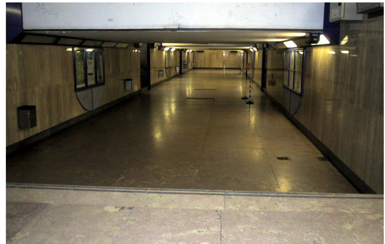
Sottopassaggio centrale. Stato di fatto.
