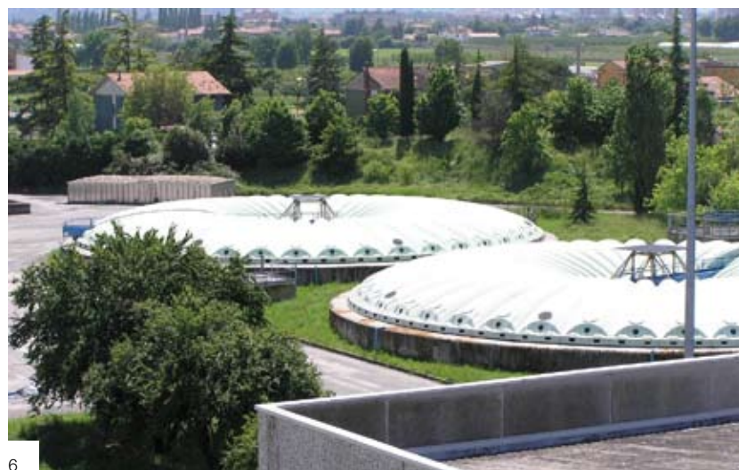
6. Depuratore di Cesena: panoramica sedimentatori primari.
