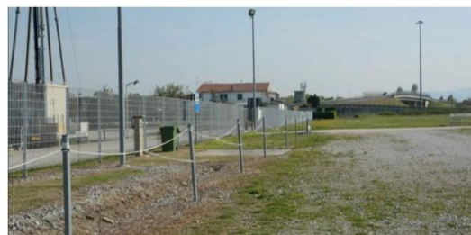
4 – Ingresso Est, cancello e recinzione esistenti
