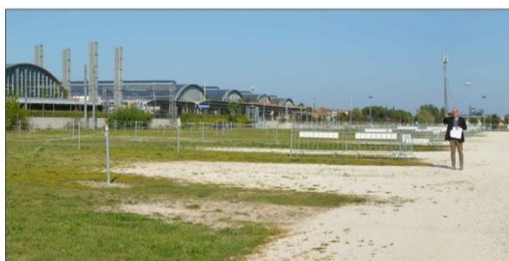
3 – Corsie di parcheggio in stabilizzato
