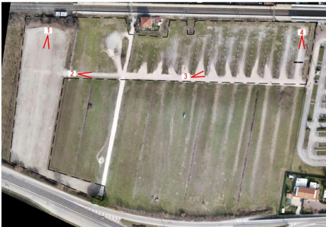
Fig.2 - Ortofoto dell'area d'intervento e punti di presa fotografica
