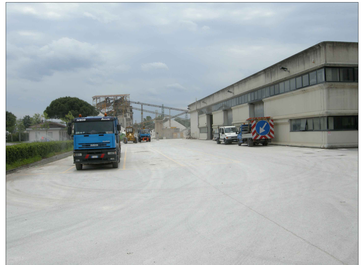
IMPIANTO ATTUALE - vista dello stato di fatto
