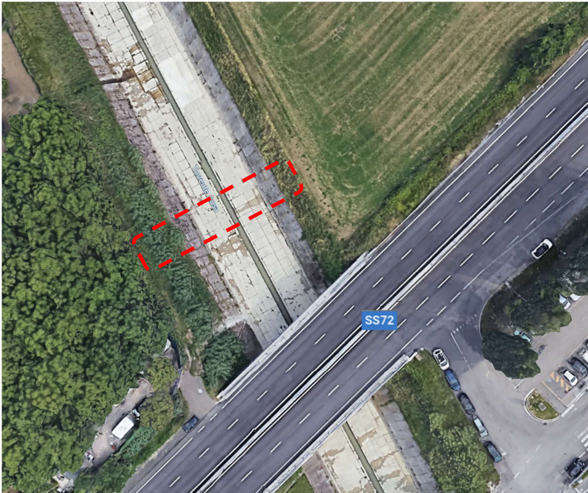
Figura 1.1 Georeferenziazione del ponte in Strada Consolare 72 Rimini – San Marino
