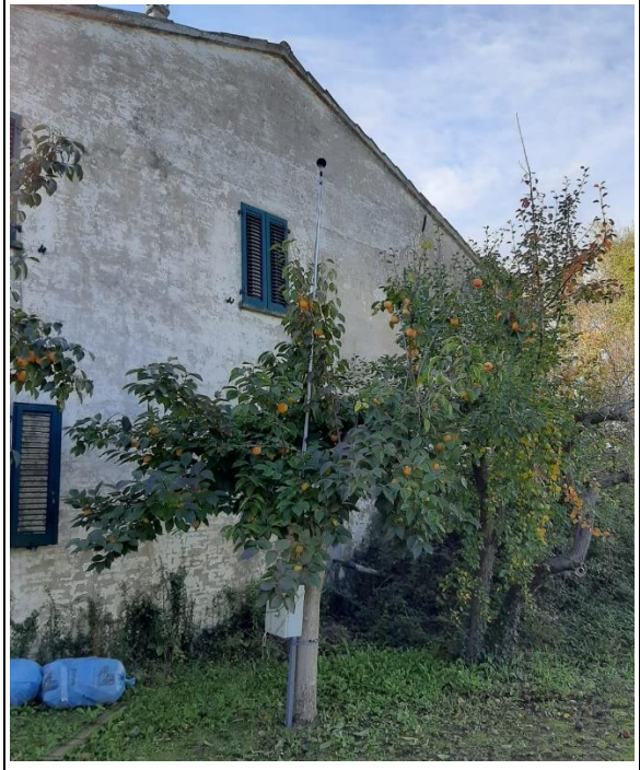
P2 - Rilievo presso R2 su SS16
