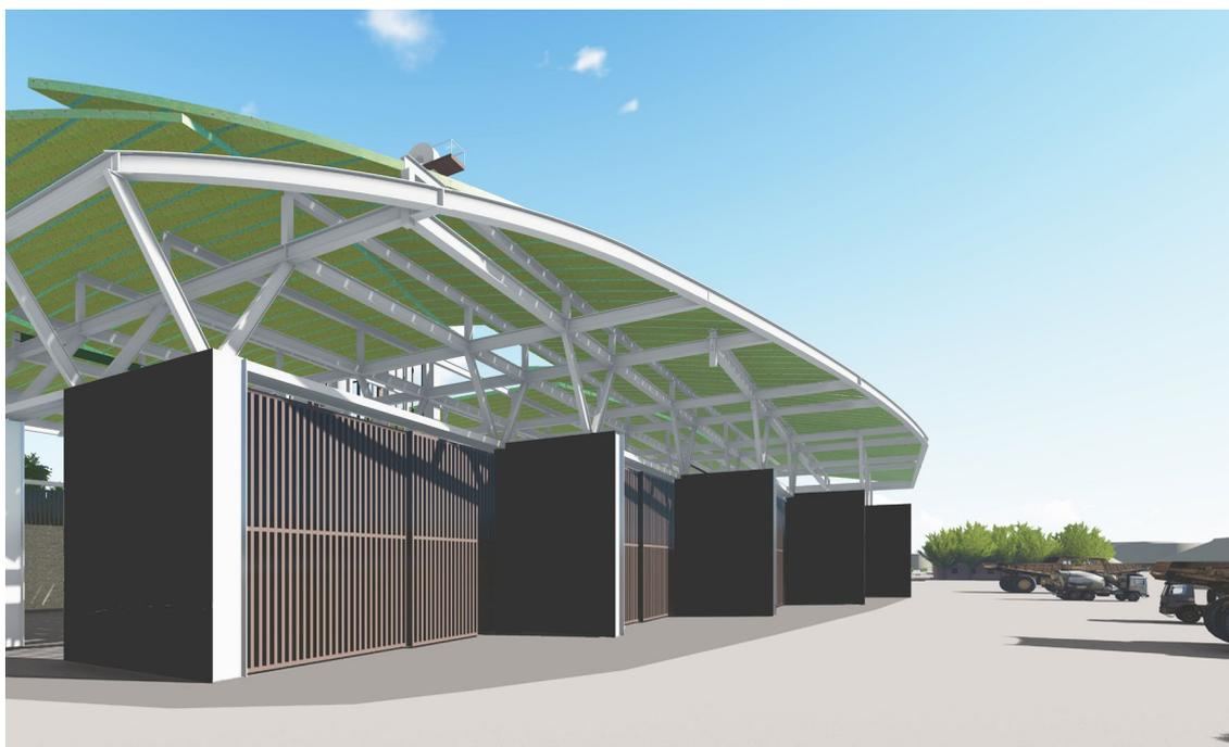
Il sistema strutturale fondazioni e pilastri e travi reticolari e spaziali in acciaio e la copertura integrata da pannelli fotovoltaici restano invariati.
