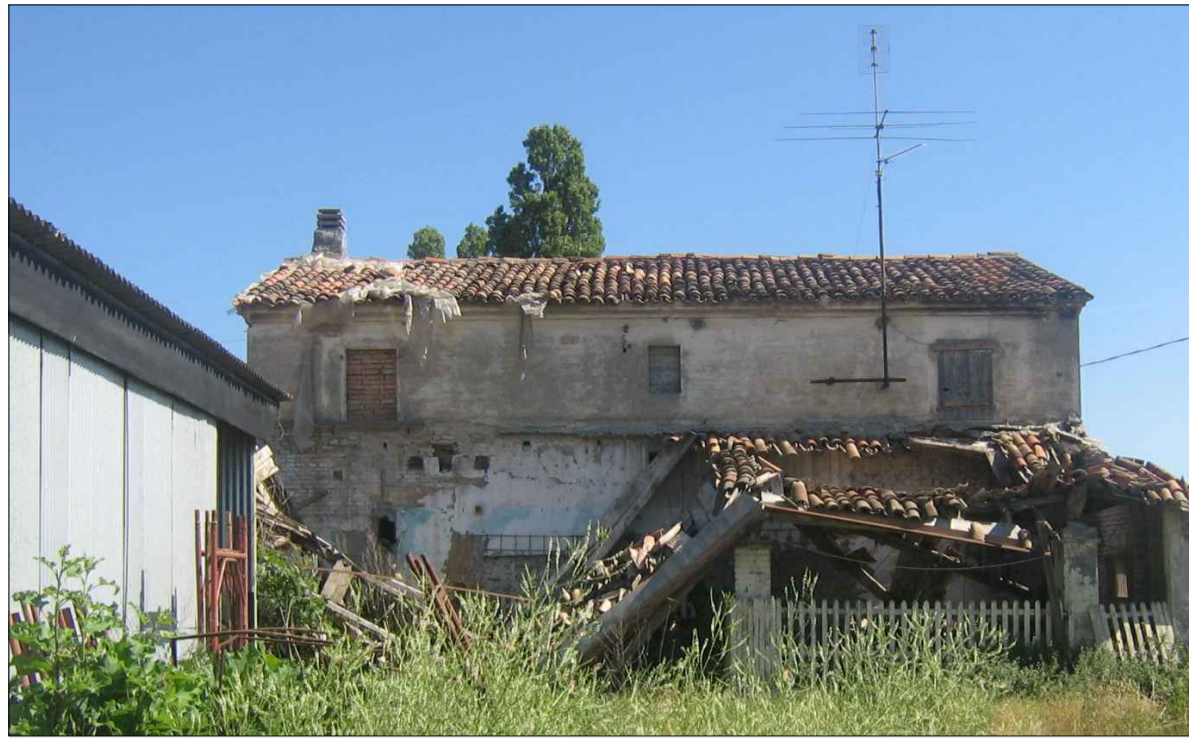
CASA COLONICA E CABINA ELETTRICA - vista dello stato di fatto
