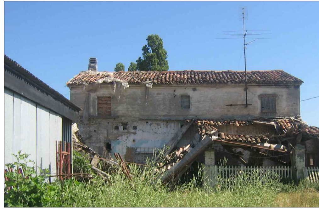
CASA COLONICA E CABINA ELETTRICA - vista dello stato di fatto
