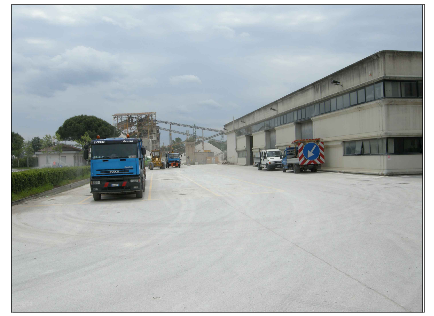
IMPIANTO ATTUALE - vista dello stato di fatto
