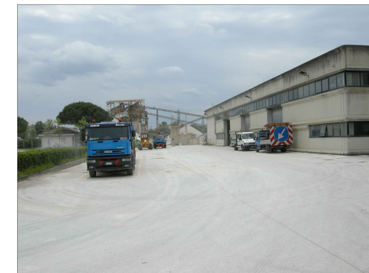
IMPIANTO ATTUALE - vista dello stato di fatto
