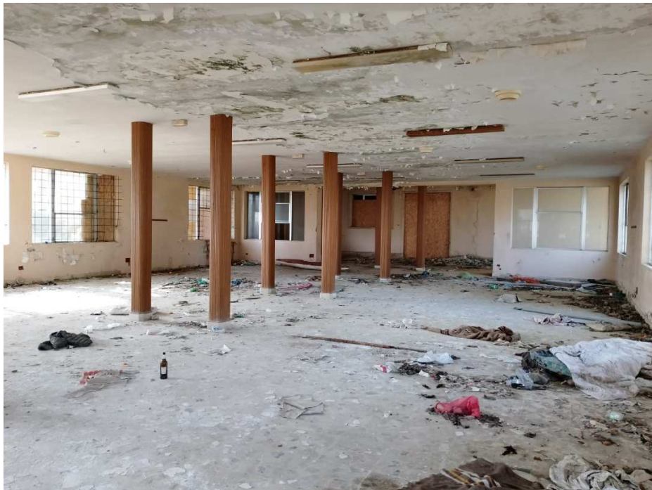
Interno: il piano terra, foto ottobre2023
