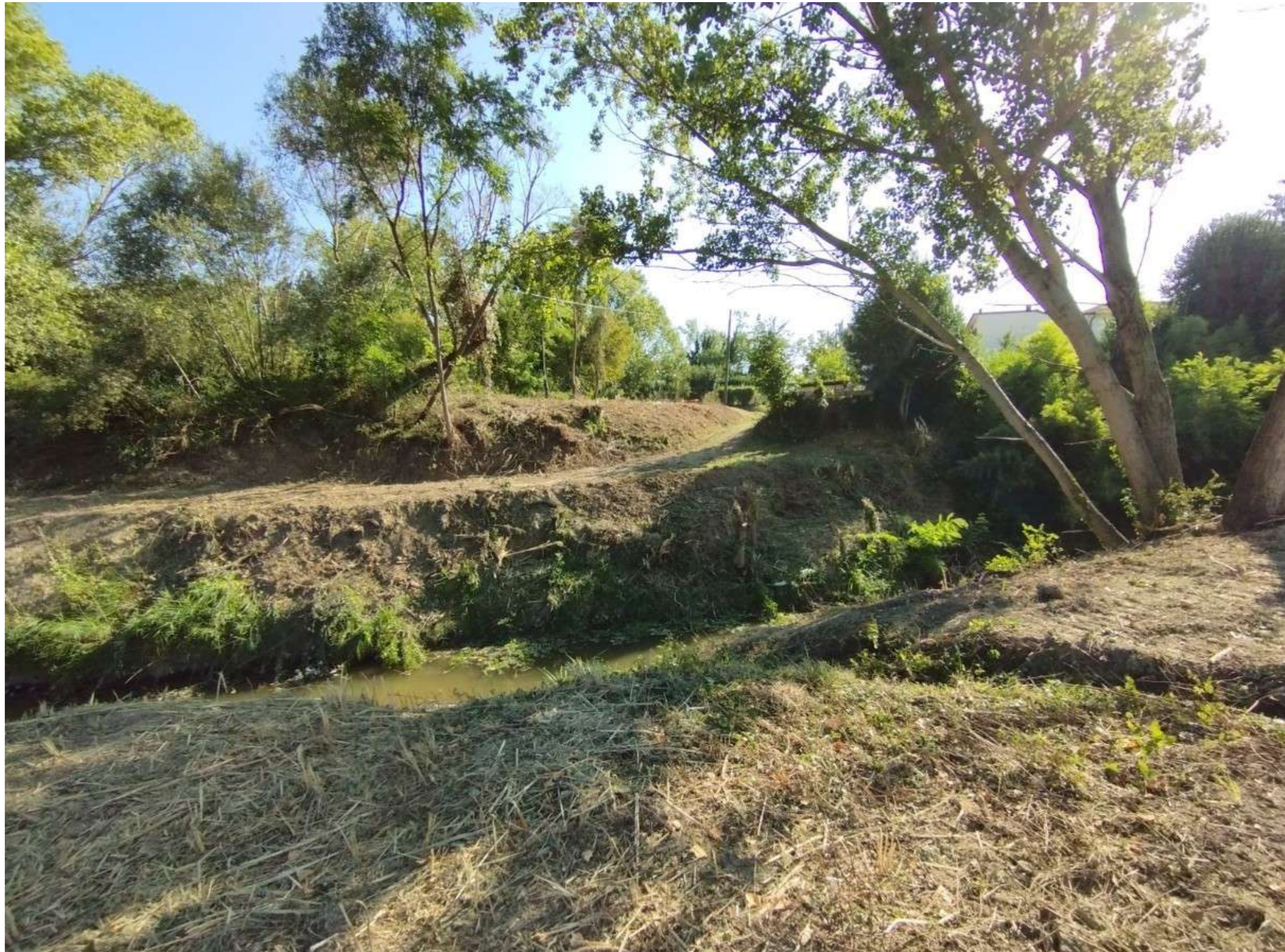
Vista da sponda in sinistra idraulica (lato via Barattona)
