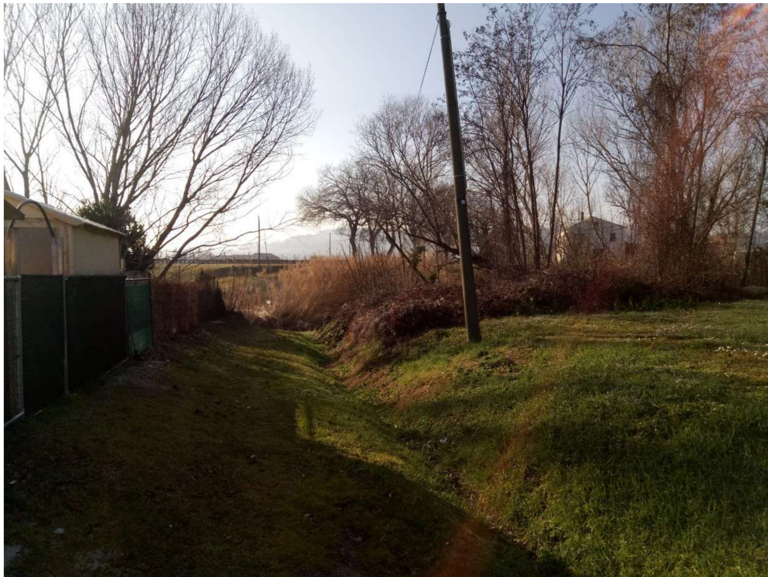
Vista dal ghetto di case ubicate lato via Montescudo (percorso discendente verso alveo torrente Ausa)
