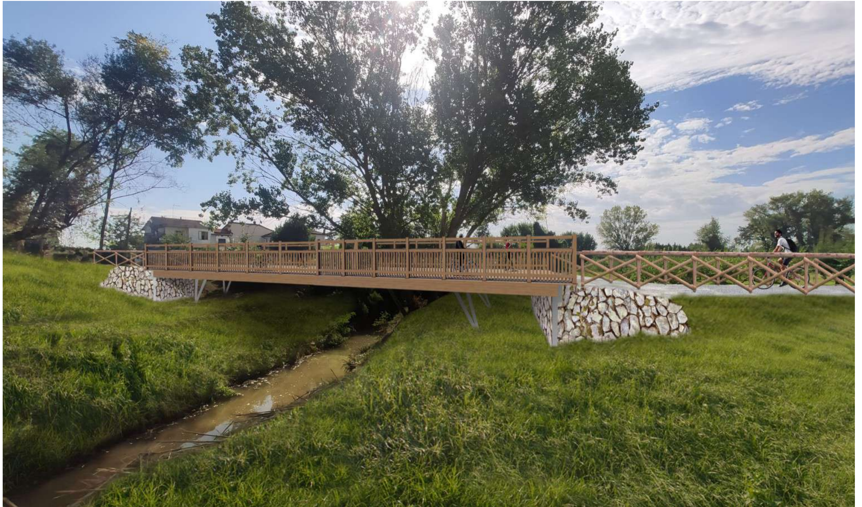
Vista da mare verso monte
