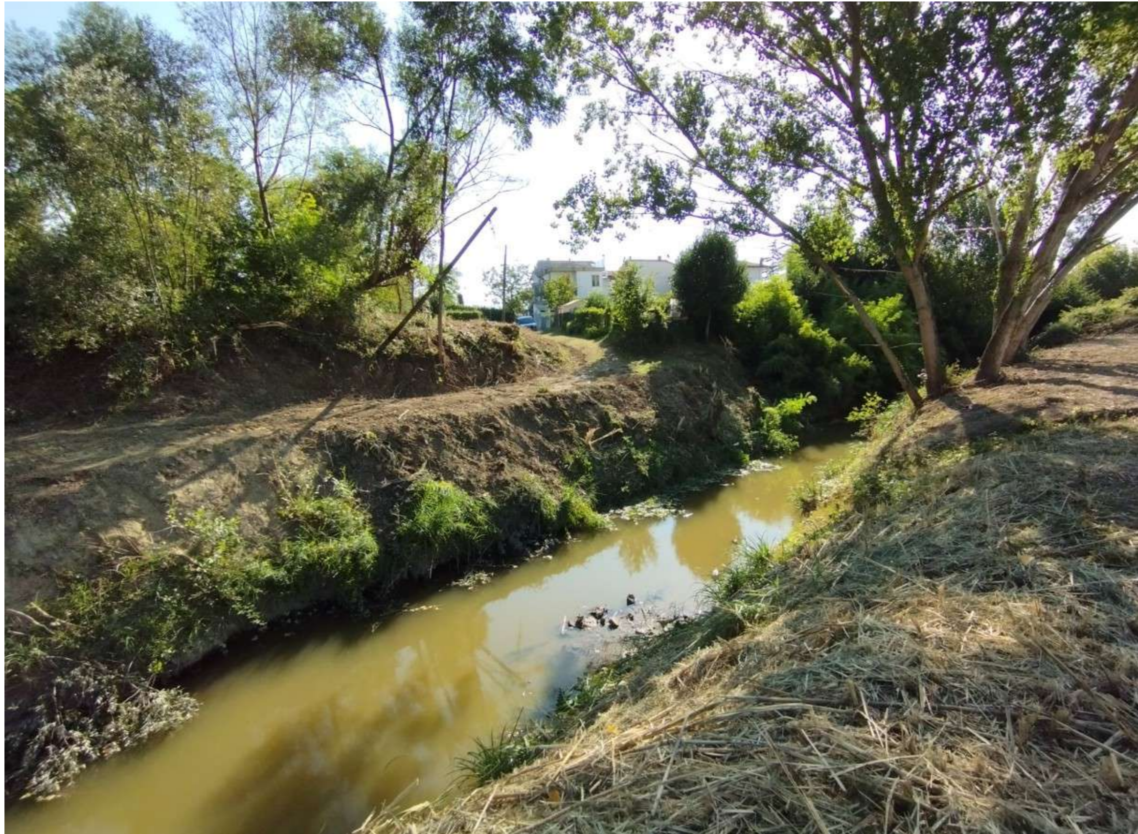
Vista da mare verso monte
