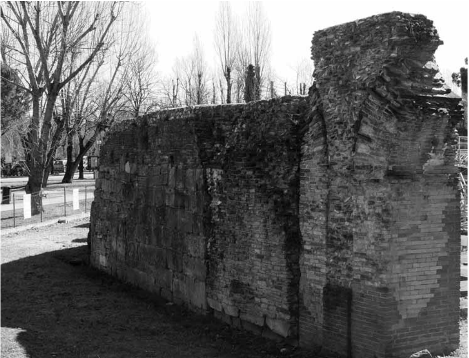
fig. 7 - Serie di tamponamenti in muratura del portico esterno dell'anfiteatro.
