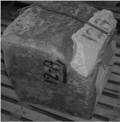
fig. 15 - I numeri neri "guida" per il rimontaggio del 1949 (Foto: SAER).
