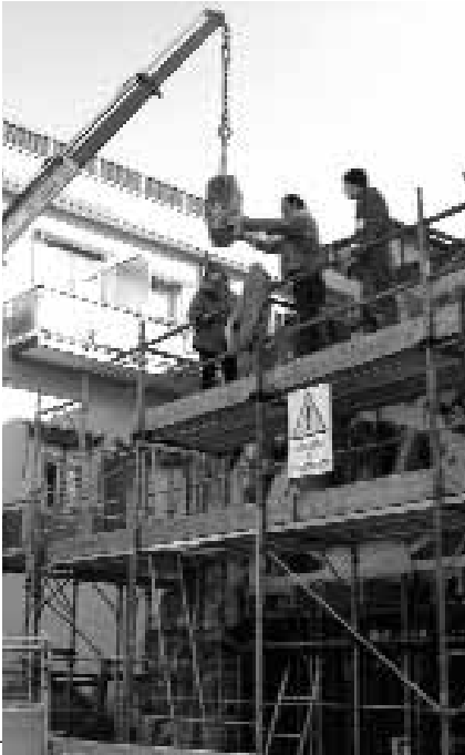
fig. 11 - Smontaggio della chiave di volta dell'arco.
