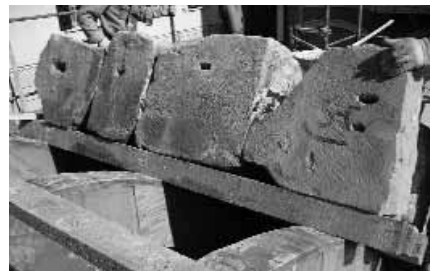
fig. 27 - Montaggio dei conci dell'arco (Foto: SAER).
