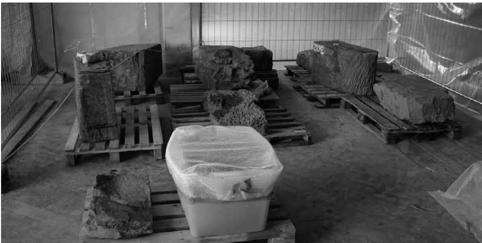
fig. 3 - Il cantiere di lavoro (Foto: 3cento laboratorio di restauro).
