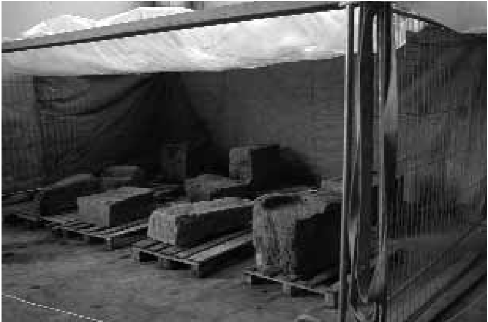
fig. 19 - Zona riscaldata per la pulizia dei blocchi (Foto: G. Giuccioli).
