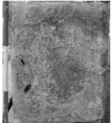
fig. 4 - Fori di tenaglie in un blocco della Porta (Foto: SAER).
