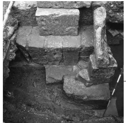
fig. 20 - Situazione ritrovata durante lo scavo del 2004 (Foto: SAER).
