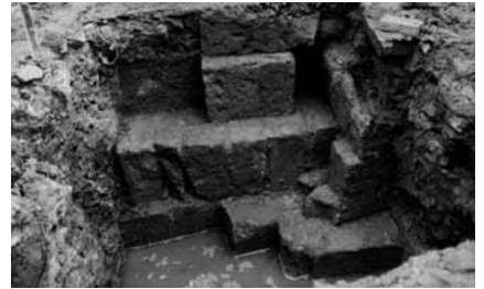
fig. 19 - Situazione dopo lo smontaggio del pilastro centrale nel 1949 (BGR, Archivio fotografico n. inv. 35815).
