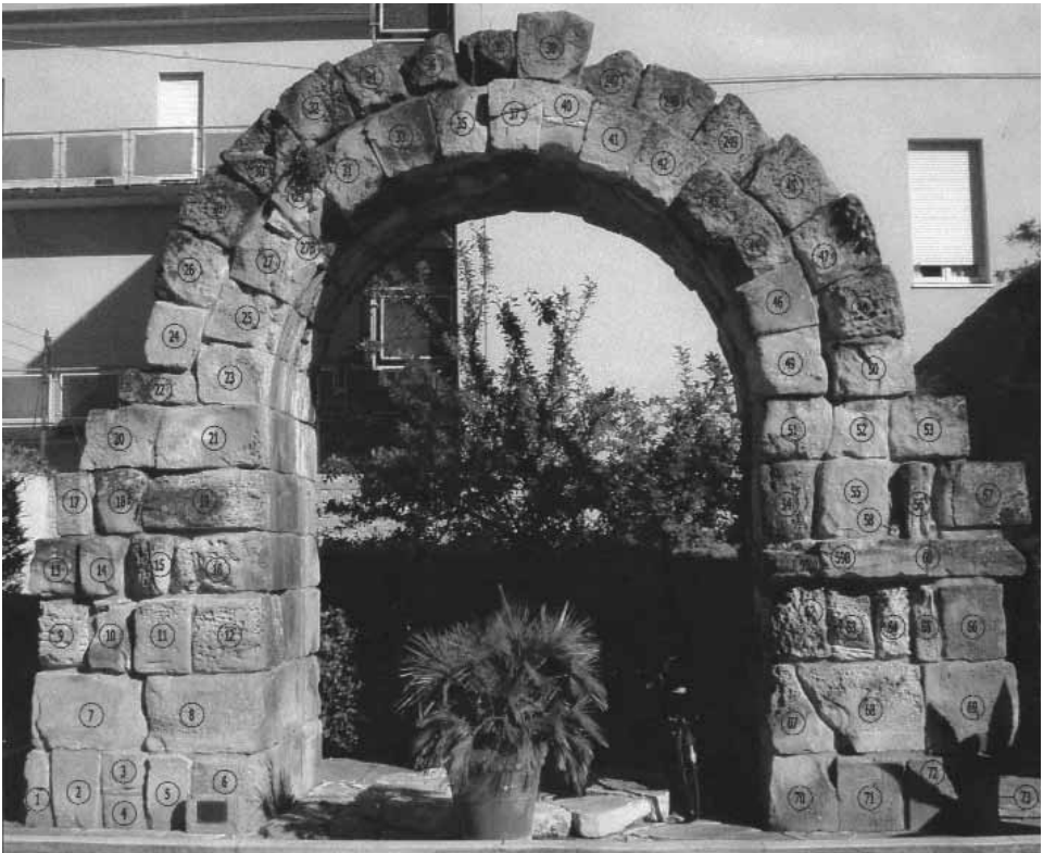
fig. 4 - Numerazione dei blocchi sul rilievo fotografico.
