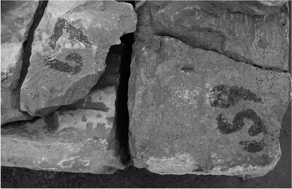
fig. 17 - Esempio di numerazione del 1949 sui blocchi (Foto: SAER).
