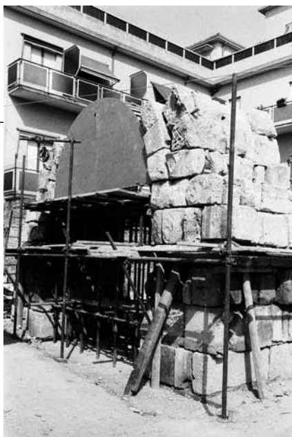
fig. 25 - Fasi dello smontaggio del 1979 (Archivio Soprintendenza per i Beni Architettonici, Ravenna).
