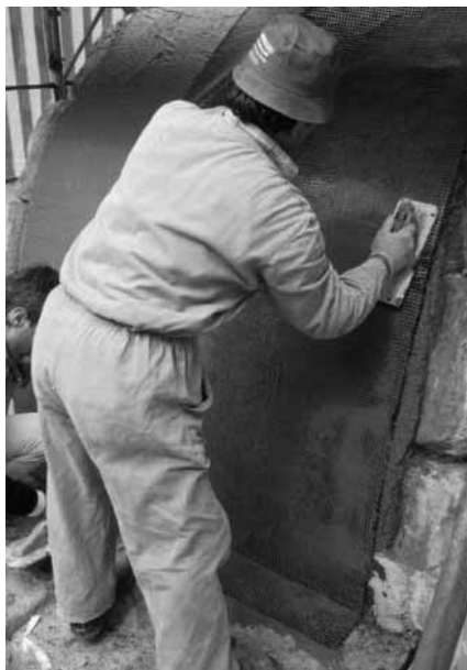
fig. 5 - Intervento con i compositi in Porta Montanara.
