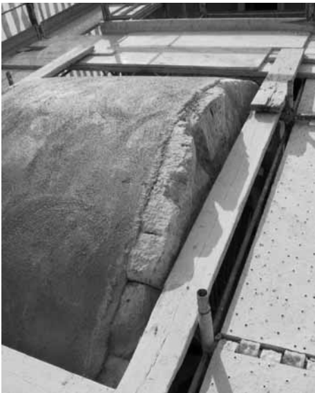
fig. 12 - Rinforzo strutturale con CFRP: secondo strato di malta allo estradosso della volta.
