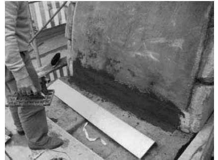
fig. 6 - Ancoraggio del composito alla base.
