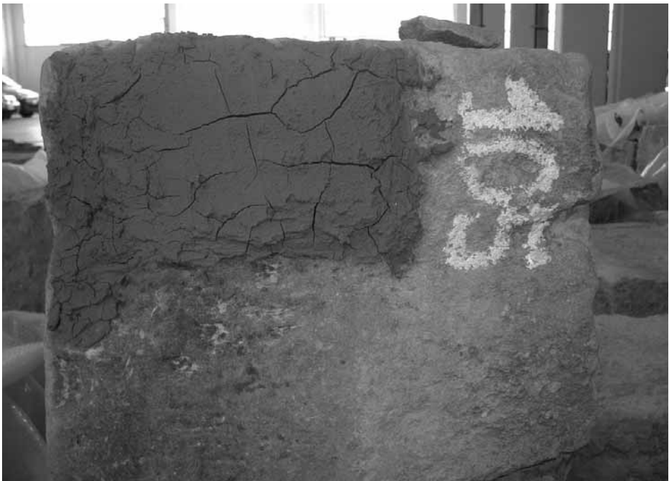
fig. 5 - Impacchi con argille assorbenti (Foto: 3cento laboratorio di restauro).
