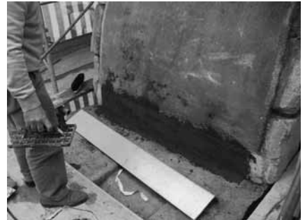
fig. 16 - Predisposizione per l'ancoraggio.
