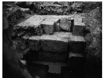
fig. 21 - Situazione dopo lo smontaggio dell'altro pilastro dell'arco nel 1949 (BGR, Archivio fotografico n. inv. 7801).
