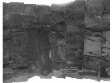
fig. 1 - Particolare dell'arco prima del restauro (Foto: 3cento laboratorio di restauro).
