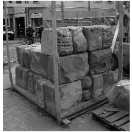
fig. 25 - Fasi del montaggio dei primi tre livelli (Foto: SAER).
