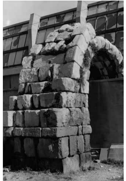
fig. 22 - L'arco di Porta Montanara a cavallo del muro (BGR, Archivio fotografico n. inv. 0211).
