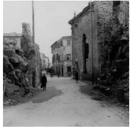
fig. 12 - L'arco distrutto e quello superstito nel 1946 (BGR, Archivio fotografico n. inv. 7796).
