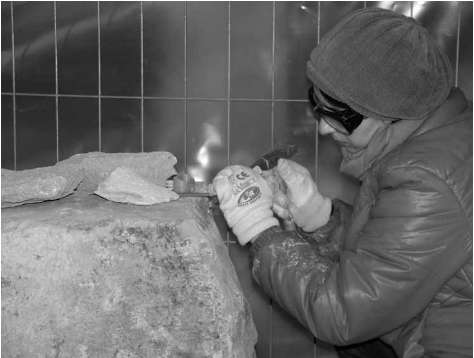
fig. 4 - Rimozione delle vecchie malte (Foto: 3cento laboratorio di restauro).
