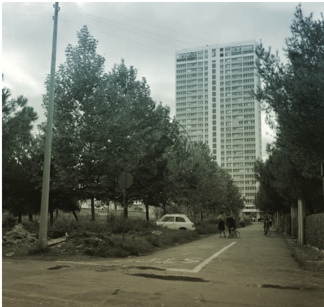
Vista da Piazzale Carso
