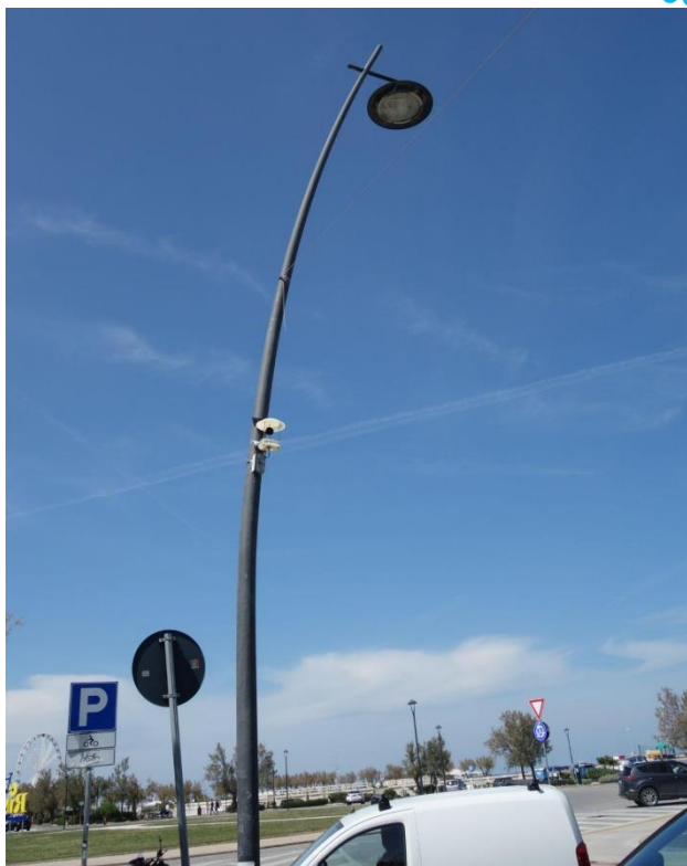
Figura 10: Sensore di rumore Via Kennedy Nord - zona di traffico
